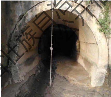
图 8.1.4 合流制排水口现场图及平面示例图
