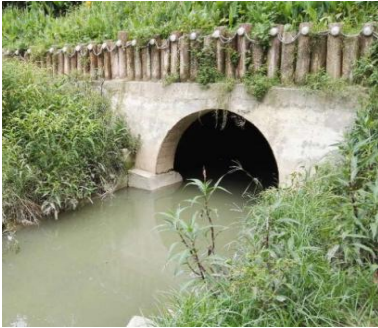
图 8.1.3 分流制雨污混流排水口现场图及平面示例图
