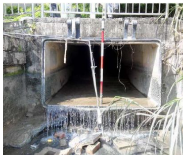
图 8.1.5 合流制溢流排水口现场图及平面示例图
